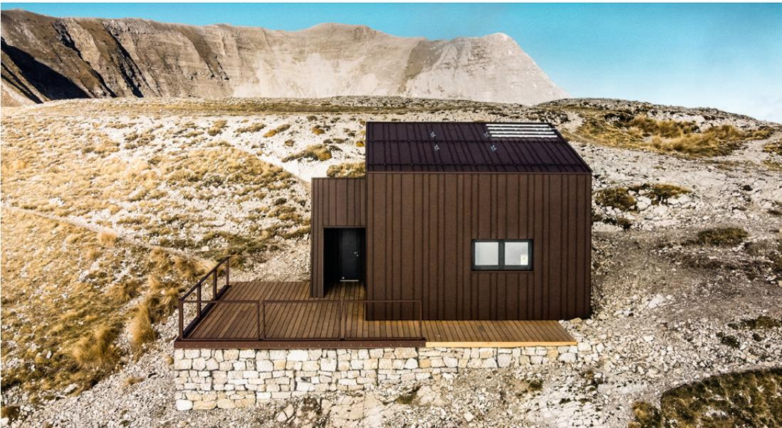
Lastre di alluminio Vestis Cortex posate con il sistema The Skin aggraffato risolvono la finitura verticale e inclinata del nuovo bivacco. Il supporto di Mazzonetto nell'elaborazione dei dettagli esecutivi e l'esperienza nella posa di Metal Roof hanno permesso la realizzazione in soli 60 giorni.
